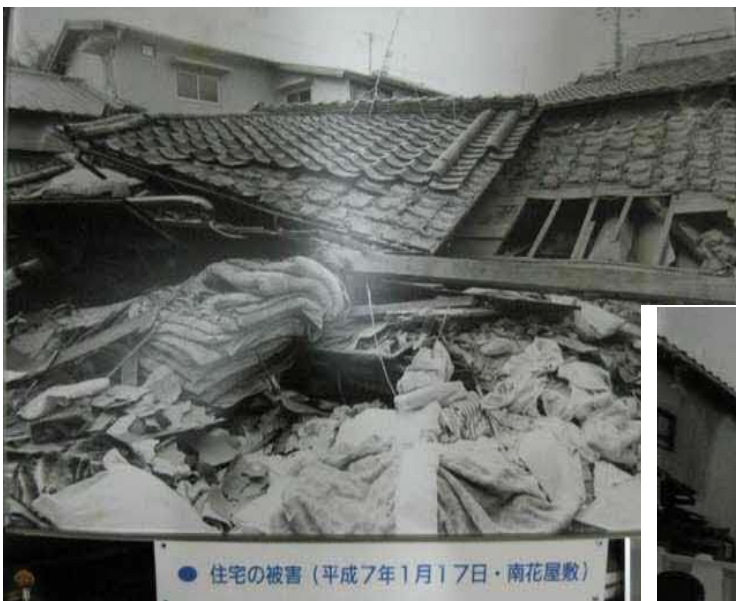
平成7年1月17日撮影 阪神・淡路大震災 川西市南花屋敷 住宅被害
