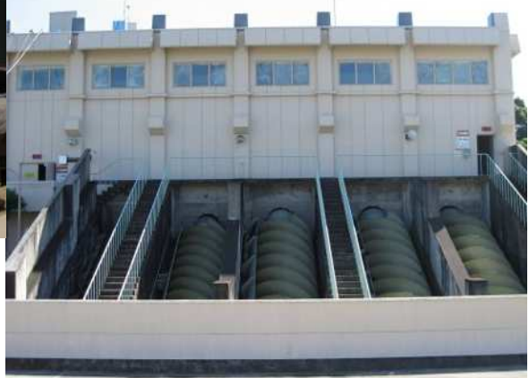
長寿命化対策工事を行う前川雨水ポンプ場
