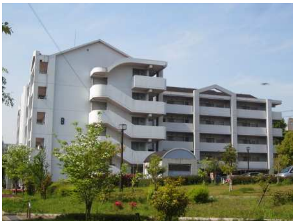
日高の市営住宅
