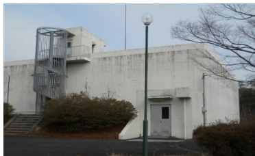
改良工事予定の 一庫高区配水池
