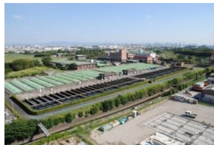
猪名川流域下水道原田処理場
