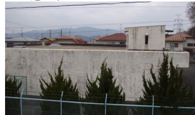
改良工事予定の 一庫低区配水池
