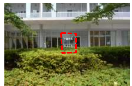
緑化スペースの中に控えめな設置にとどめた例（豊中市）
