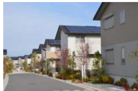
落ち着いた外壁色で統一し、かつ環境共生のまちとして緑化や太陽光パネルを積極的に導入した例（堺市・晴美台エコタウン）
