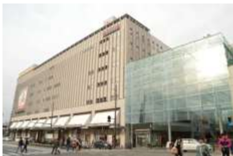
商業施設と接続するガラスの空間を挿入し、市民が集う新たな空間となった例（富山市・グランドプラザ）
