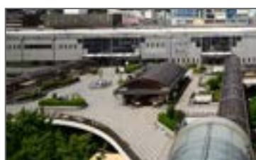
道路空間活用箇所例(川西能勢口駅前デッキ)
