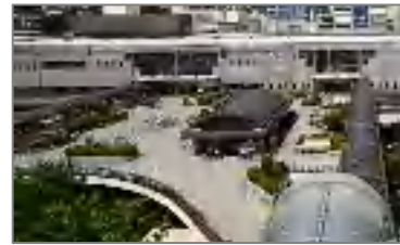
道路空間活用箇所例(川西能勢口駅前デッキ)
