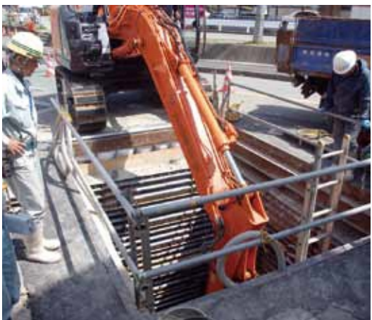
雨水管きよ整備工事 (矢問バス停付近)
