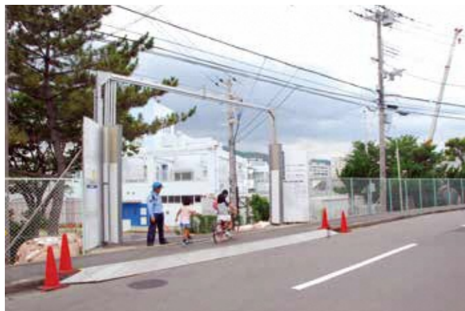
川西こども園工事現場
