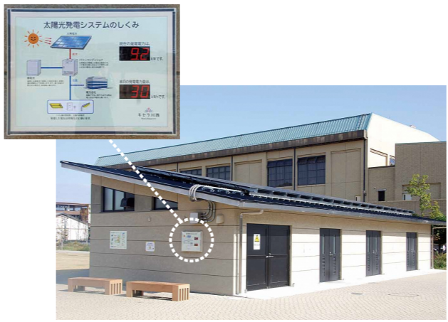
キセラ川西せせらぎ公園内のトイレ倉庫棟
