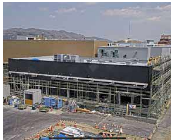
建設中の川西市中学校給食センター
