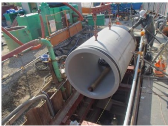
雨水管きょ築造工事
