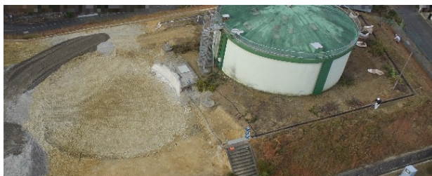
清和台低区配水池
