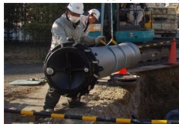
老朽化した送水管の改良工事
