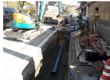
污水管きょ築造工事
