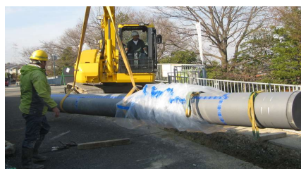
老朽化した送水管の改良工事
