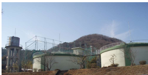
清和台低区配水池
