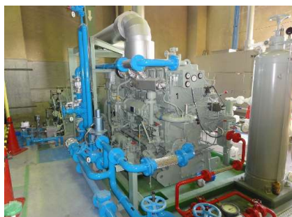
雨水ポンプ場 長寿命化工事
