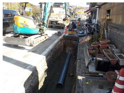
管きよ築造工事
