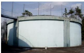
緑台高区2号配水池
