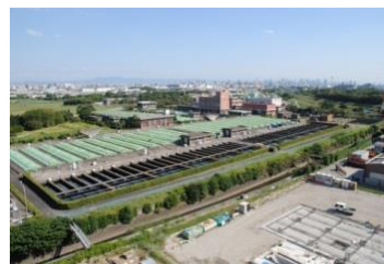
市内の汚水処理を行う 猪名川流域下水道原田処理場
