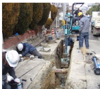
老朽化した配水管の改良工事
