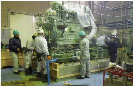
雨水ポンプ場 長寿命化工事
