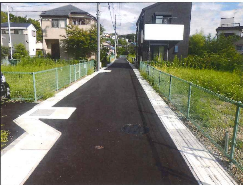
写真区分: 着手前及び完成写真 工種: 完了
