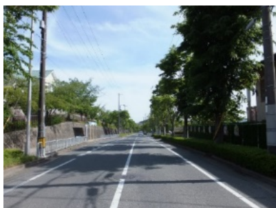
日生ニュータウン内の市道
