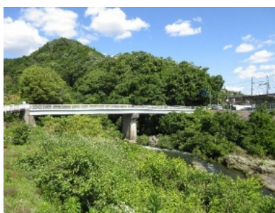
一庫付近の橋梁（道路）
