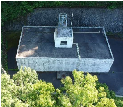
けやき坂高区配水池
