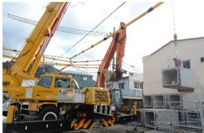
雨水管きょ築造工事
