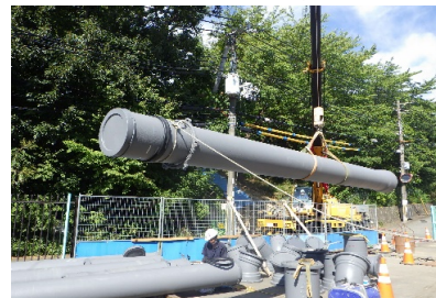
老朽化した送水管の改良工事
