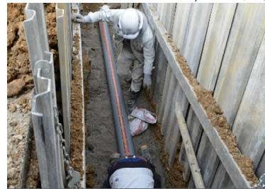
污水管きょ築造工事
