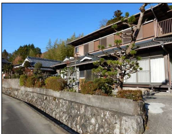
石積み擁壁と敷地植栽①
