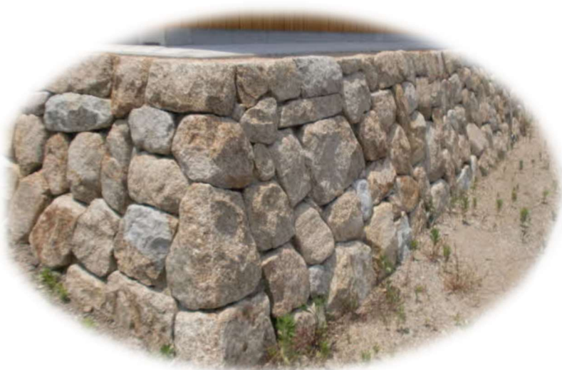
石(自然石)積み擁壁
