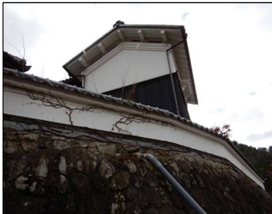
漆喰による外壁
