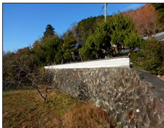
石積み擁壁と敷地植栽②
