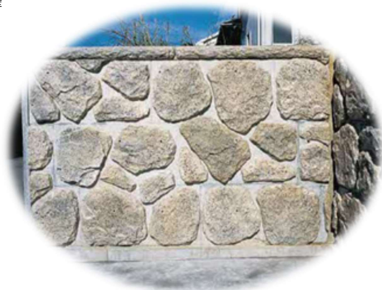
化粧型枠を使用した擁壁
