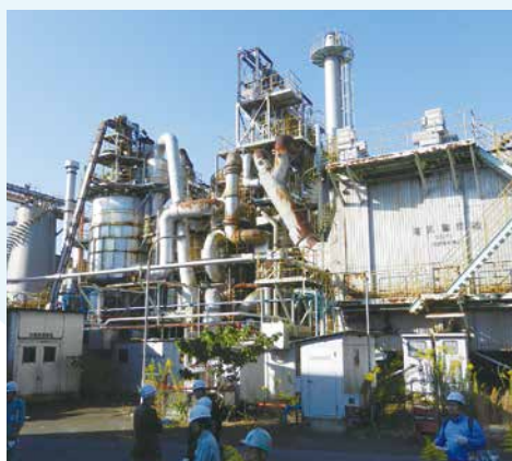
污水前処理場
