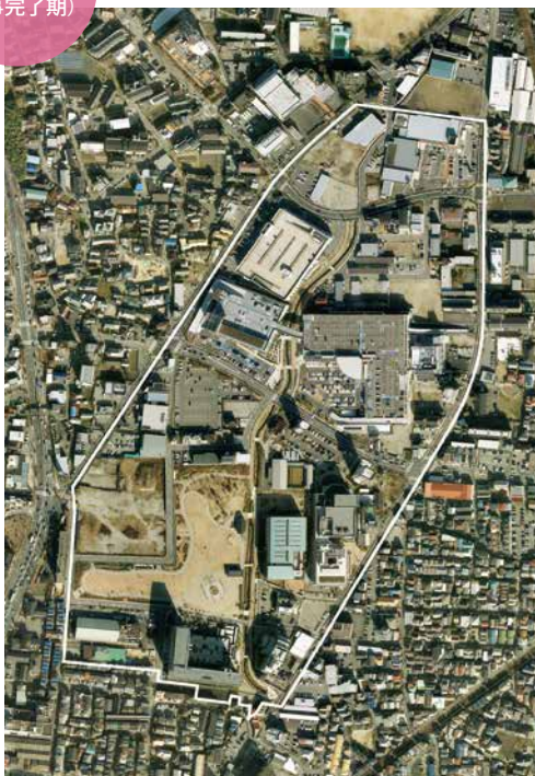
令和2年(工事完了期)
