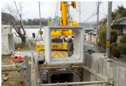
雨水管きょ築造工事
