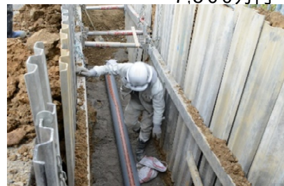
汚水管きょ築造工事
