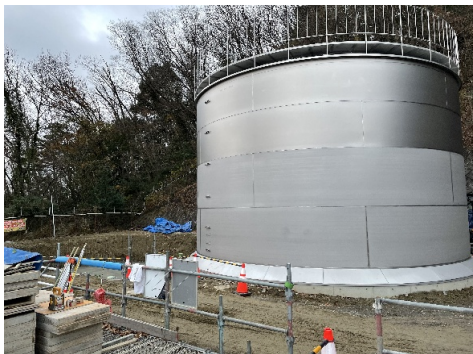
けやき坂高区配水池
