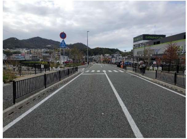
■豊川橋山手線(施工後)
