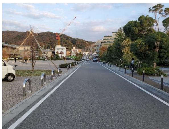
■区画道路第6号(施工後)
