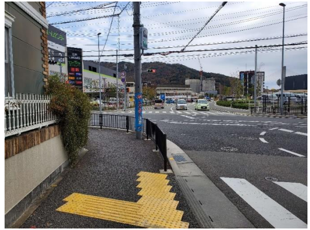
■豊川橋山手線 - 火打滝山線 交差点付近(施工後)
