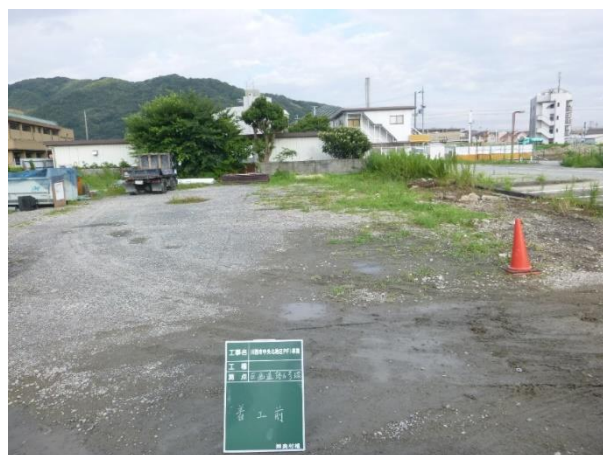
■区画道路第6号(施工前)
