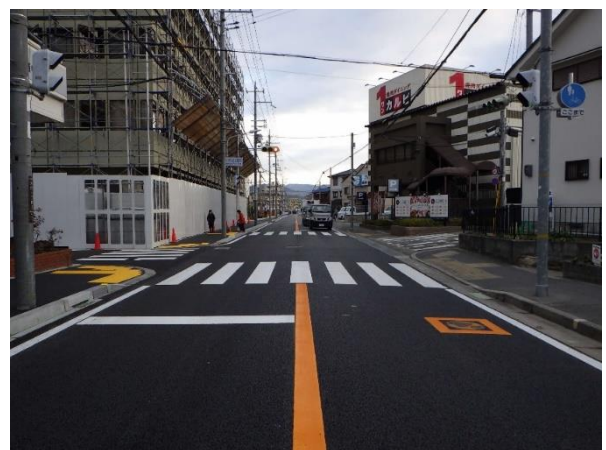
■小花滝山線(施工後)
