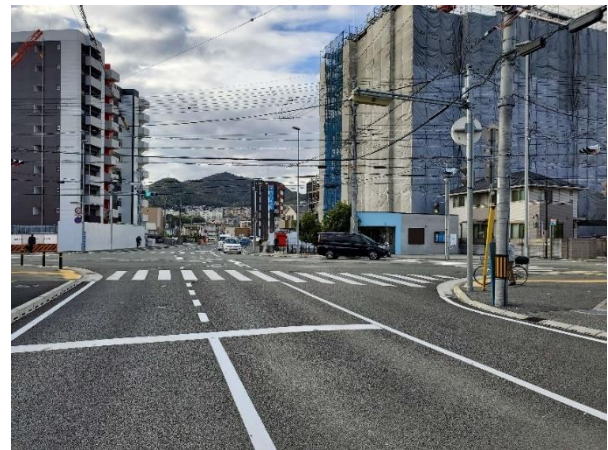
■豊川橋山手線 - 小花滝山線 交差点付近(施工後)
