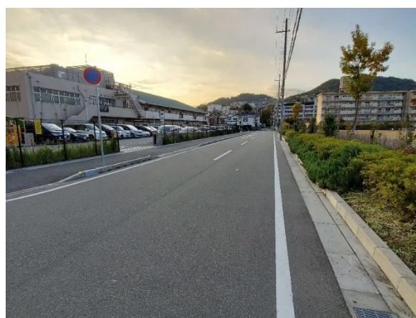
■区画道路第3号(施工後)
