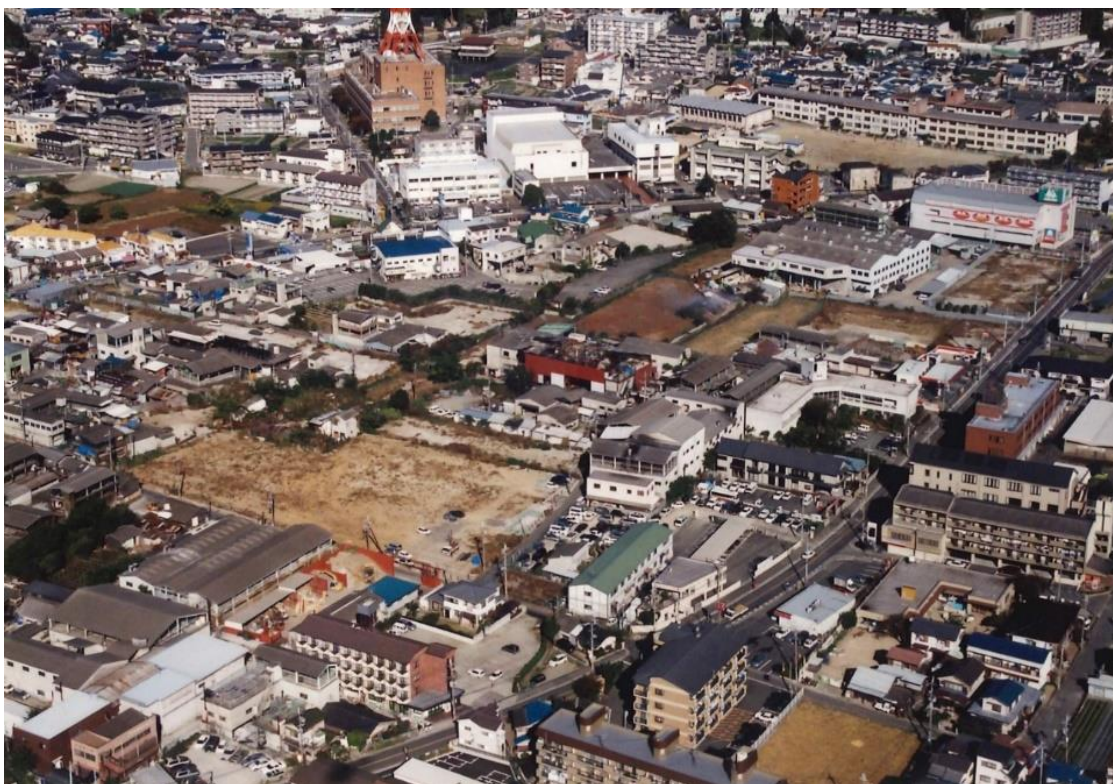
■平成 11 年の施行地区(南東より撮影)とその周辺
