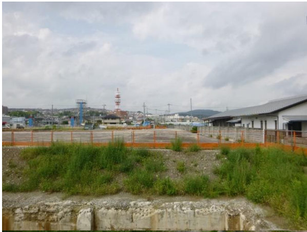
■せせらぎ遊歩道南線(施工前)
