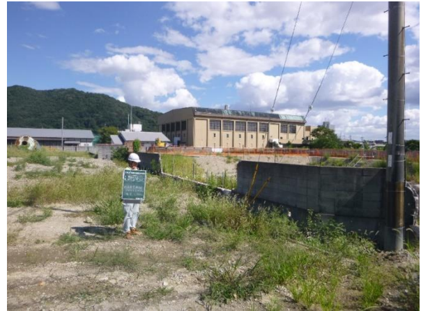
■キセラ川西せせらぎ公園(雨水貯留槽)施工経過
