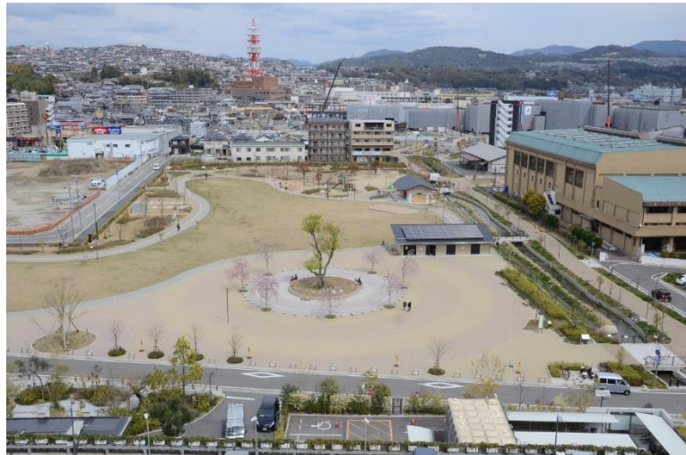
■キセラ川西せせらぎ公園(施工後)
