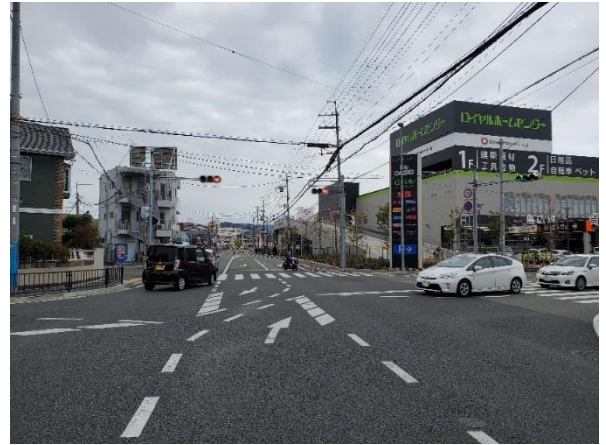
■火打滝山線(施工後)
