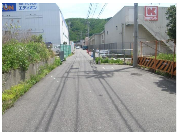
■区画道路第13号(施工前)
