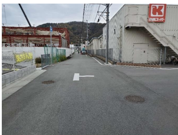
■区画道路第13号(施工後)
