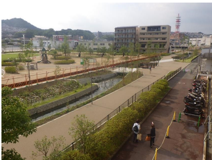
■キセラ川西せせらぎ公園 - せせらぎ遊歩道南線(施工後)
