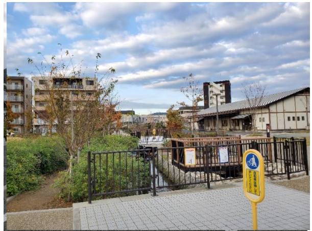
■せせらぎ遊歩道南線(施工後)
