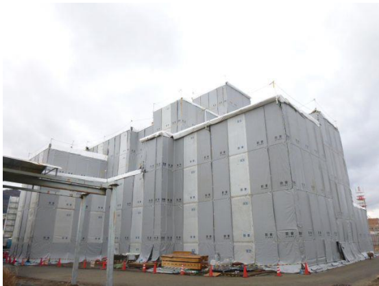
■写真11 火打前処理場の解体工事
