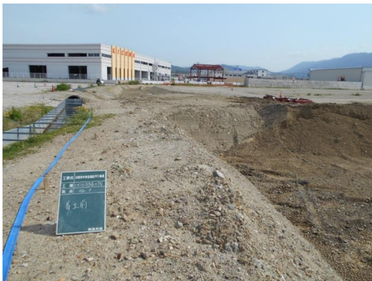
■せせらぎ遊歩道北線(施工前)
