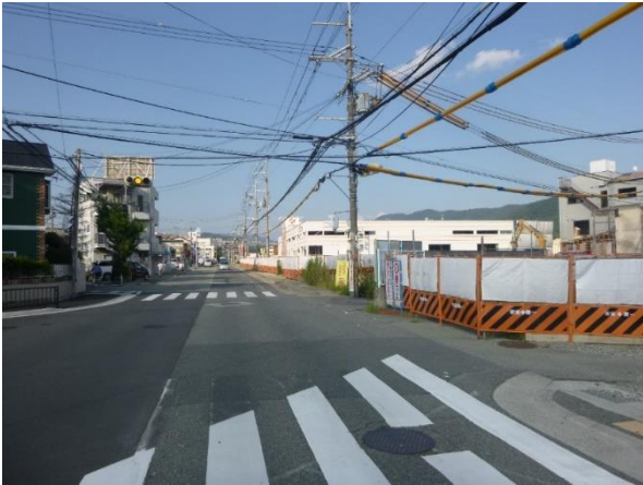
■火打滝山線(施工前)
