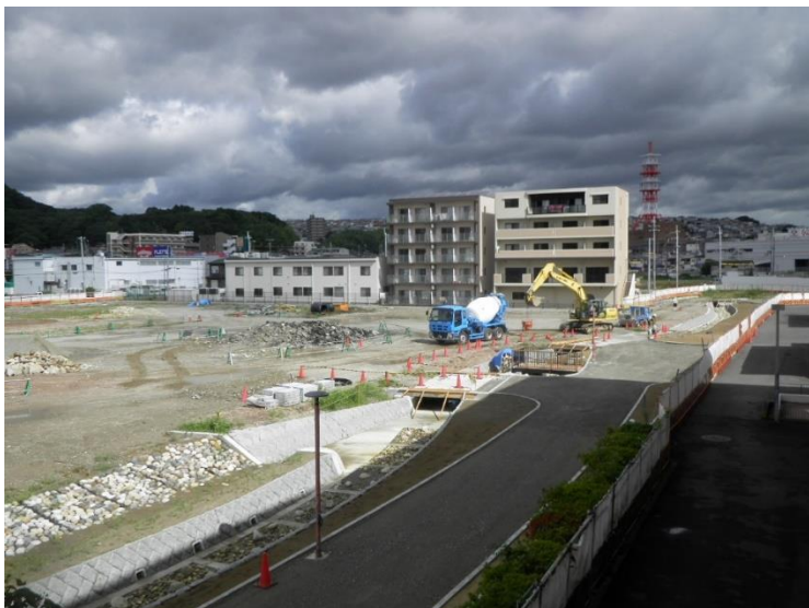
■キセラ川西せせらぎ公園 - せせらぎ遊歩道南線(施工中)
