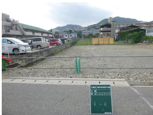
■区画道路第3号(施工前)
