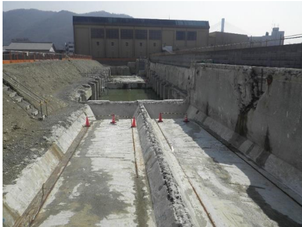
■キセラ川西せせらぎ公園(汚水貯留槽)施工経過
