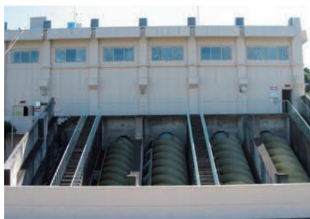
前川雨水ポンプ場
