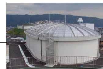
萩原台配水池
