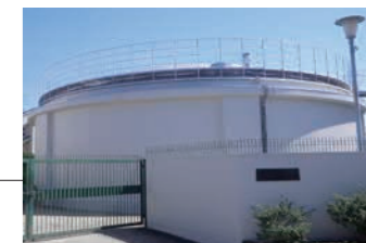
大和低区配水池
