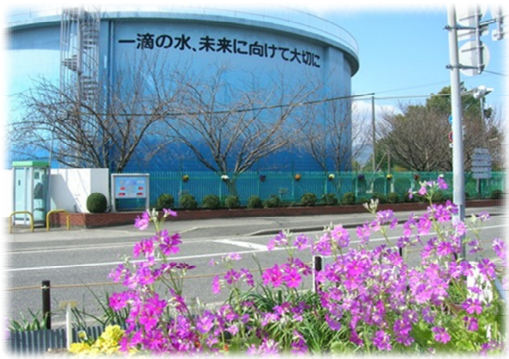
久代浄水場 (久代配水池)
