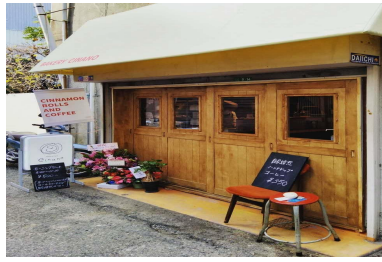
新規出店内装工事
