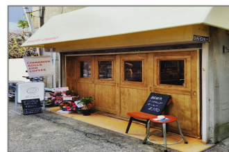
新規出店内装工事
