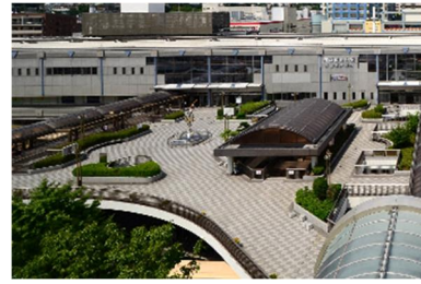
道路空間活用箇所例（川西能勢口駅前デッキ）
