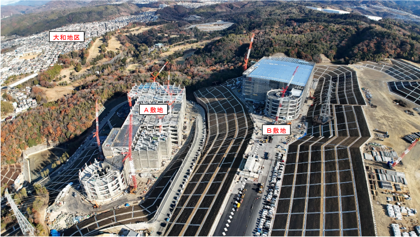
A敷地・B敷地の工事状況（南面より）
