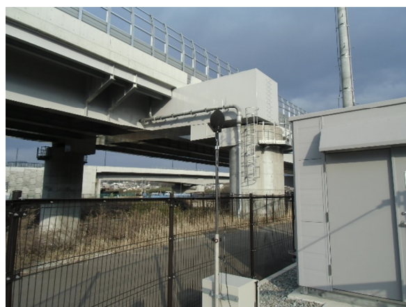
【図 7-3 測定の様子（川西文珠橋局）】
